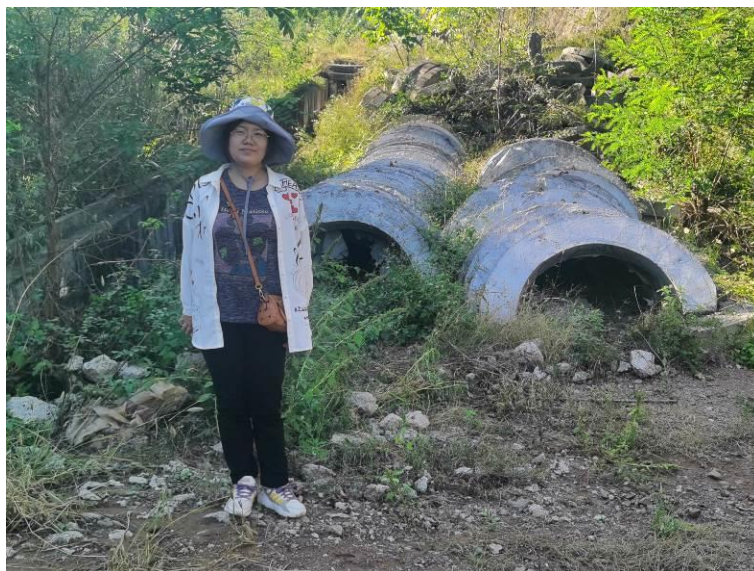
照片 11 已检测排水斜槽盖板
