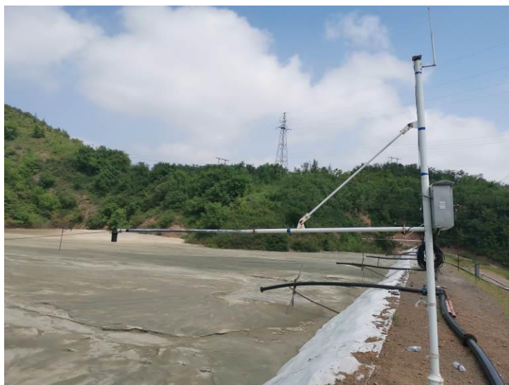
照片 18 坝顶干滩监测
