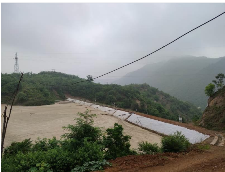
照片 23 尾矿库滩面
