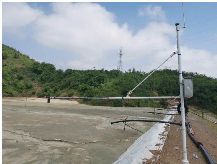
照片 6 堆积坝坝顶
