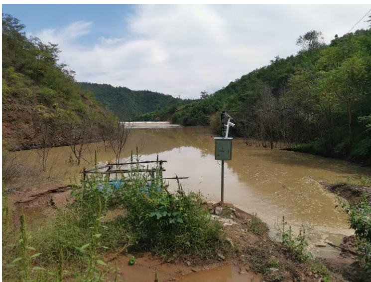
照片 17 水位计和进水口视频
