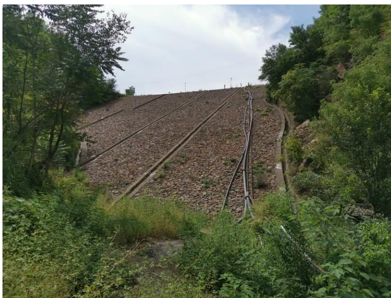
照片 2 初期坝外坡
