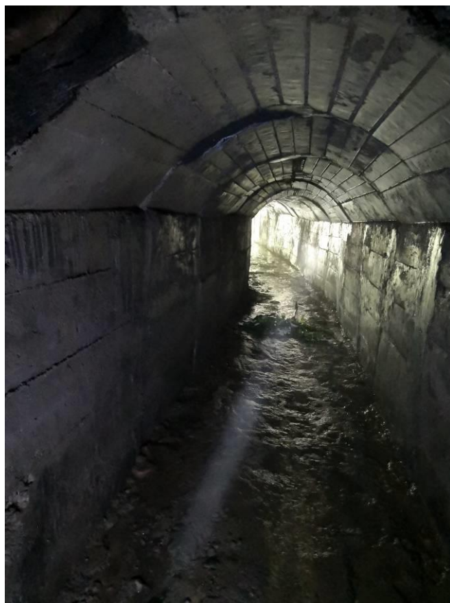
照片 12 排水隧洞衬砌
