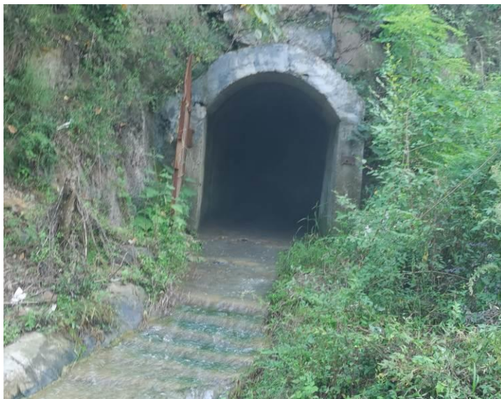
照片 13 隧洞出口
