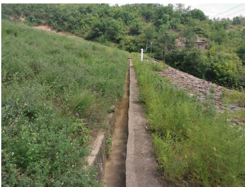
照片 3 初期坝坝顶
