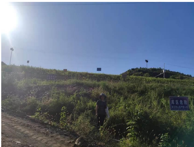
照片 28 坝体增设警示标志
