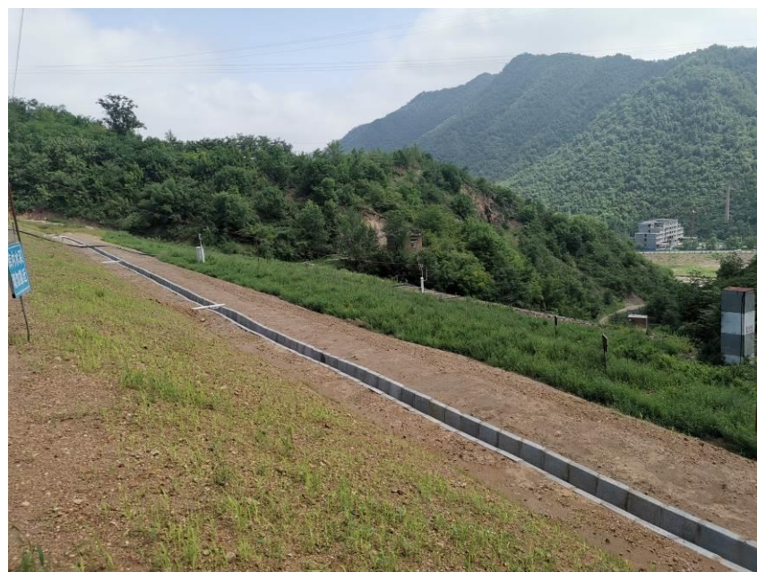
照片 5 第四、五级堆积坝外坡
