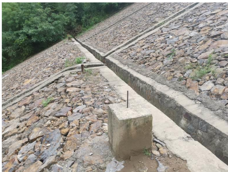
照片 15 初期坝马道位移观测标桩及浸润线观测管
