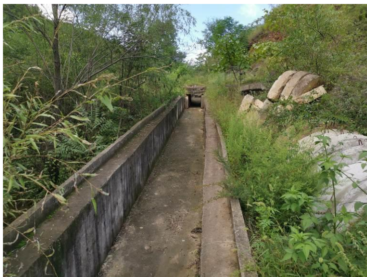
照片 8 排水斜槽
