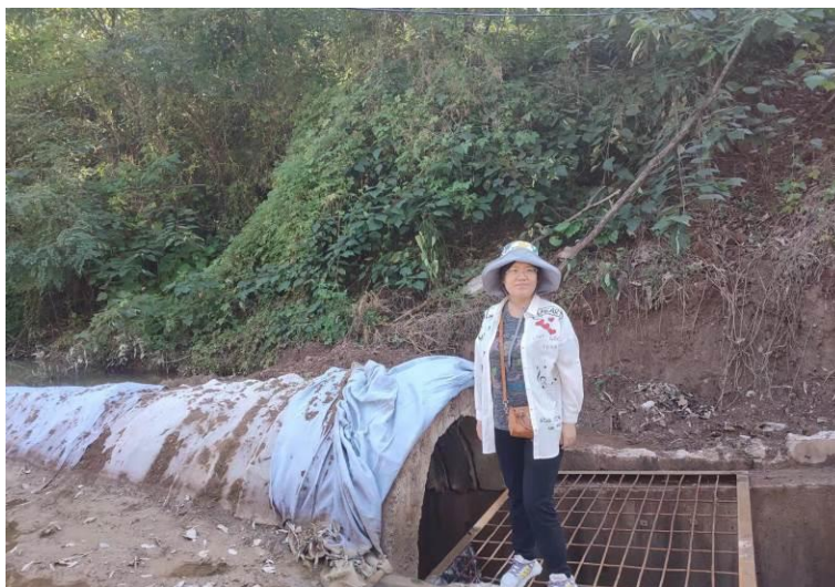
照片 10 排水斜槽进水口
