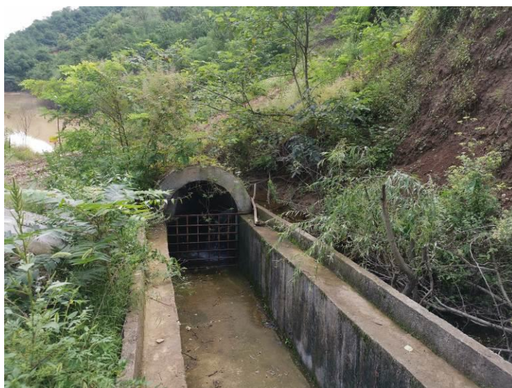
照片 9 排水斜槽上游进水口
