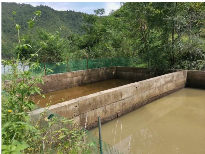
照片 14 安装护网的回水池
