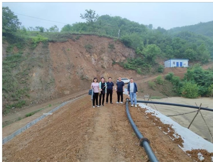
照片 7 堆积坝坝顶
