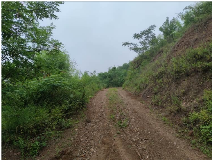
照片 25 入库道路
